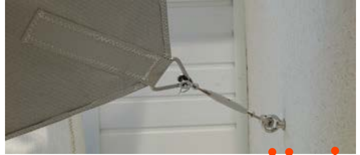
Point d'ancrage avec tendeur
