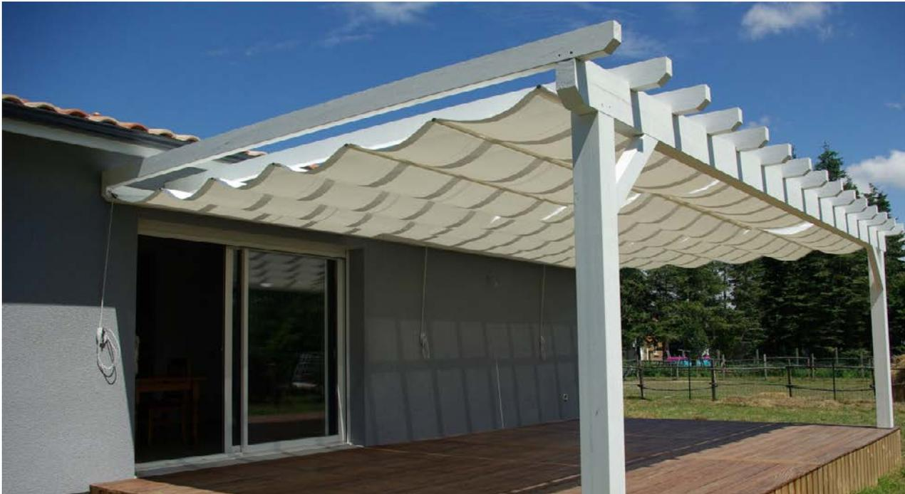
*Système de toile tendue sur câbles, manoeuvrable en ouverture et fermeture par cordage.*
