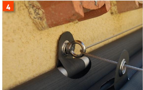
**3** Détail du passage des câbles dans les passants et pitons, tendre le tendeur afin qu'il n'y ait plus de flèche au niveau des câbles.
